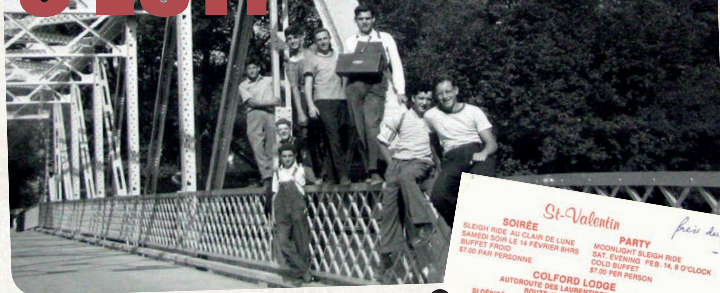
Des élèves du Collège commercial de Saint-Jérôme prennent la pose sur la structure du pont Mackenzie en 1948 (Saint-Colomban-Saint-Canut) Source : HAL, Fonds Angers Dessurcault, Po82, S4, D2, Po3
